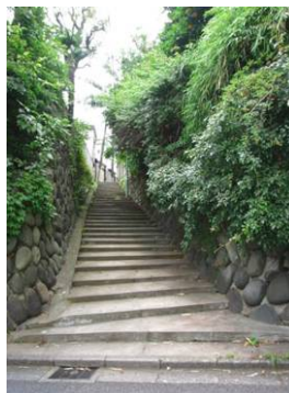
石積みの擁壁 (藪下通り脇の坂道 千駄木1丁目)
