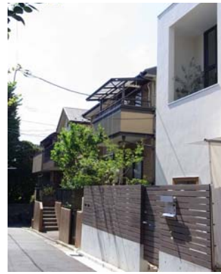
外壁の凹凸や自然素材を用いたルーバーなどの外構の工夫が見られる低層集合住宅（小日向）
