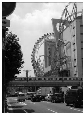
遊園地の施設と 地下鉄丸ノ内線（本郷）
