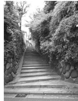
石積みの擁壁 (藪下通り脇の坂道 千駄木1丁目)
