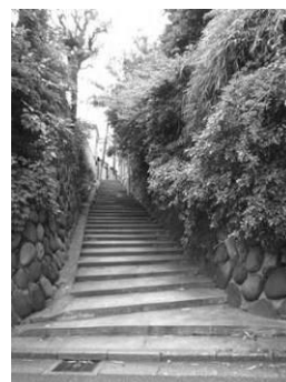
石積みの擁壁 (藪下通り脇の坂道 千駄木)
