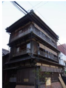
明治時代に建てられた木造の建物 (根津)
