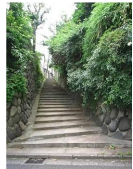
石積みの擁壁 (藪下通り脇の坂道 千駄木)
