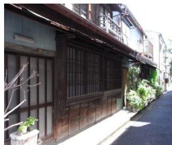
路地沿いに建つ木造の長屋 (根津)
