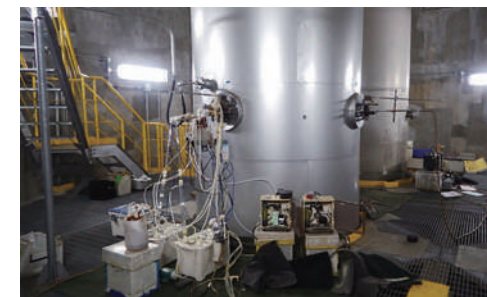
排ガス採取の状況（杉並清掃工場）
