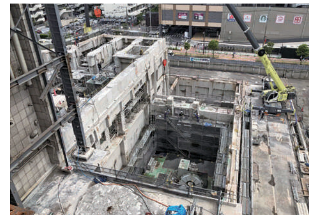
工場棟の解体工事（北清掃工場）
