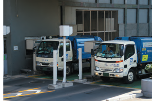
ごみ計量機 (墨田清掃工場)
