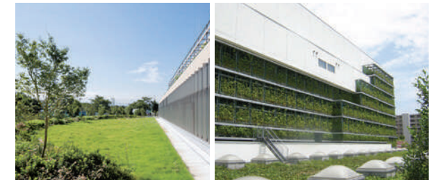
屋上緑化 (杉並清掃工場)
