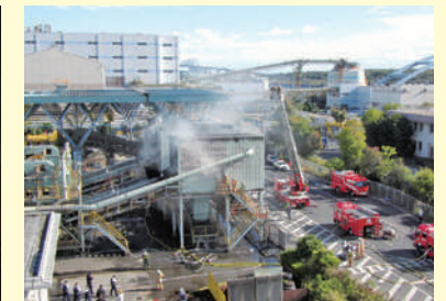
粗大ごみ破碎処理施設での火災
