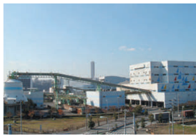
中防不燃ごみ処理センター (江東区海の森)
