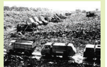
可燃ごみの一部を直接埋め立てていた昭和40年代の埋立処分場
