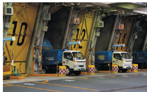
ごみの搬入の様子（足立清掃工場）
