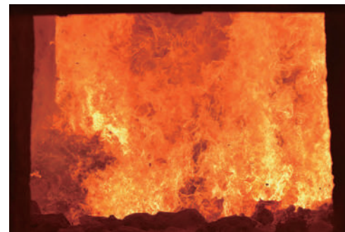
焼却炉内部の様子 (杉並清掃工場)
