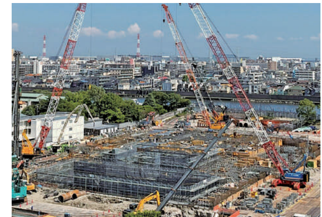
建設工事の全景（江戸川清掃工場）
