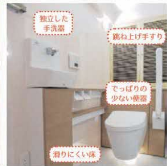
■バリアフリーに配慮したトイレの一例
