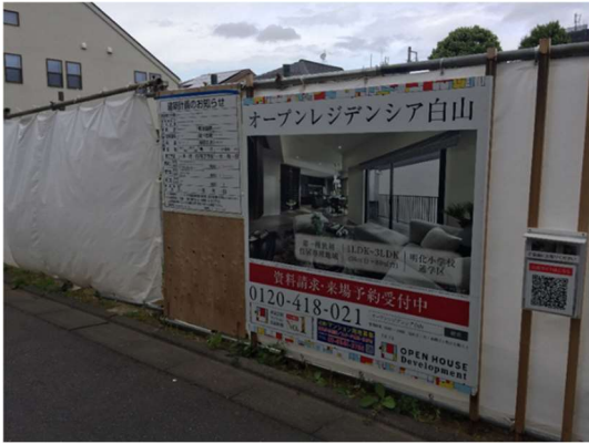
マンション建設予定地(白山四丁目)
