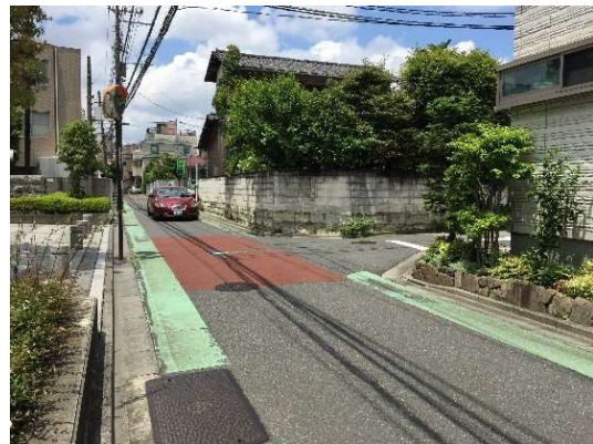
住宅街の道路（千石二丁目）
