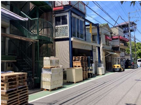
住工混在の地区（白山三丁目）
