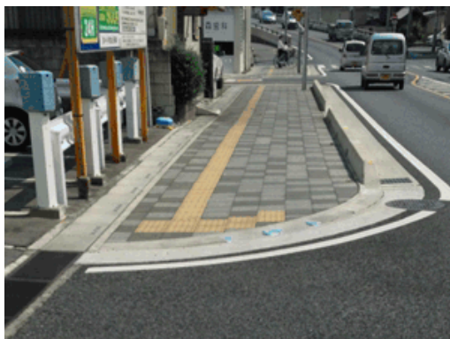
バリアフリー化された歩道
