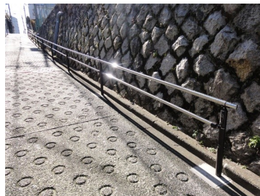
急な坂道への手すりの設置
