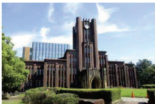
大講堂（安田講堂） 【歴史的建造物の保全及び風致の維持】
