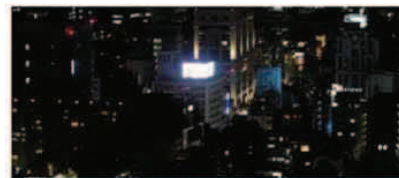
遠くから目立つ屋上に設置されたデジタルサイネージ
