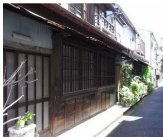
路地沿いに建つ木造の長屋 (根津)
