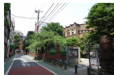
東大のレンガ積みファサード・塀
