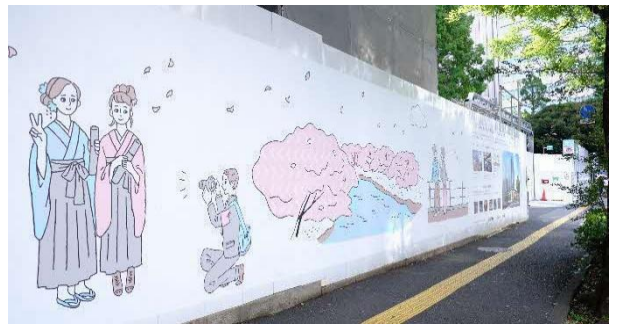
旧九段会館建替え工事の仮囲い広告物（千代田区）
