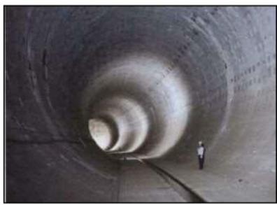
神田川・環状七号線地下調節池（既設）
