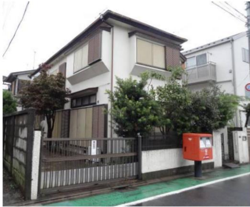
改修工事前(外観)
