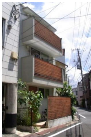
バルコニーに木の素材感を意識した素材を用いている建物
