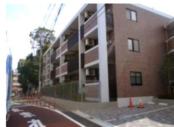
部分的に外壁の色を変えた例
