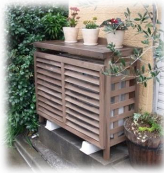
室外機の目隠し
