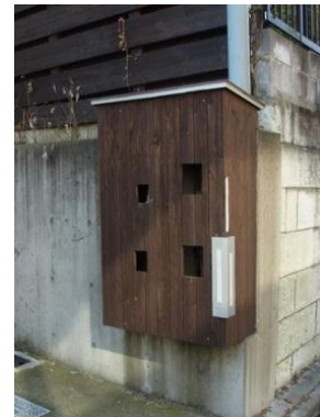
メーターボックスを目隠ししている例
