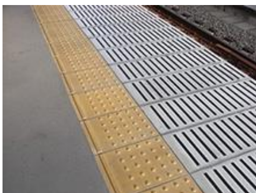
内方線付点状ブロック
