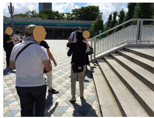
写真 4 手すりや視覚障害者誘導用ブロックのない階段
