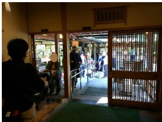
写真 18 柵のない建物内スロープ
