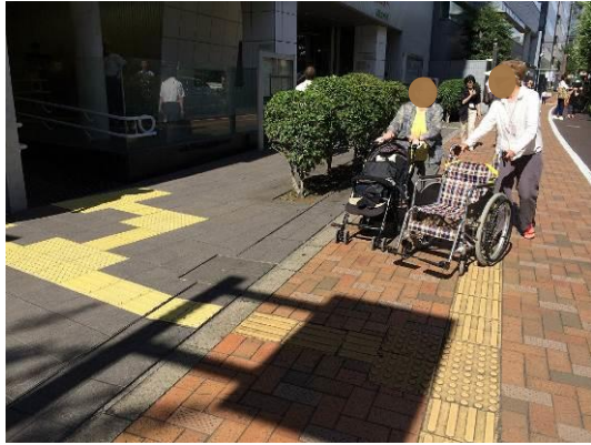
写真 22 すり減って分かりにくい視覚障害者誘導用ブロック（写真左側部分）
