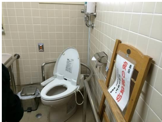
写真 16 便器が斜めに設置されたトイレ
