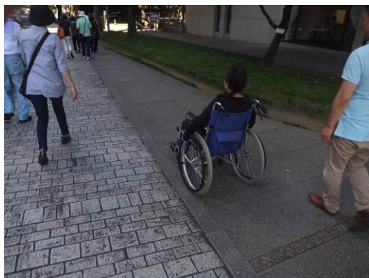
写真1 横方向の勾配がきつい歩道
