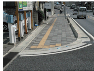
バリアフリー化された歩道
