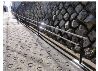
急な坂道への手すりの設置
