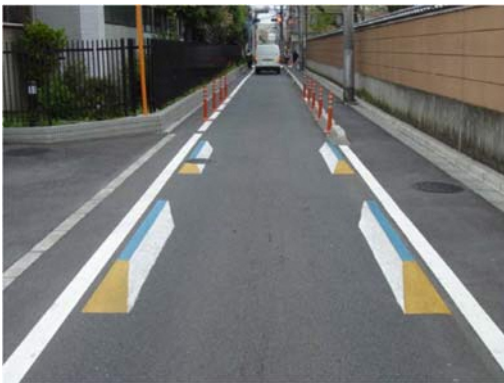
コミュニティ道路（歩道なし：路面表示）
