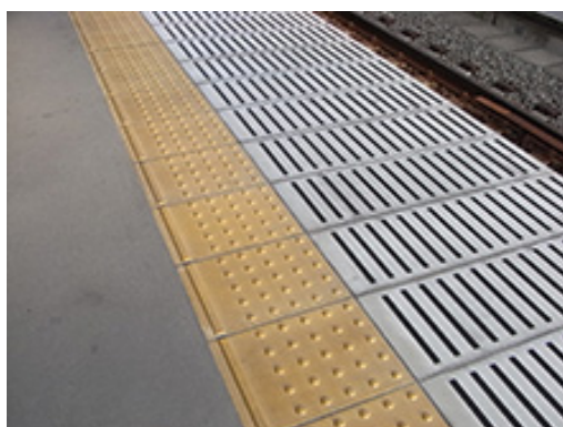
内方線付点状ブロック
