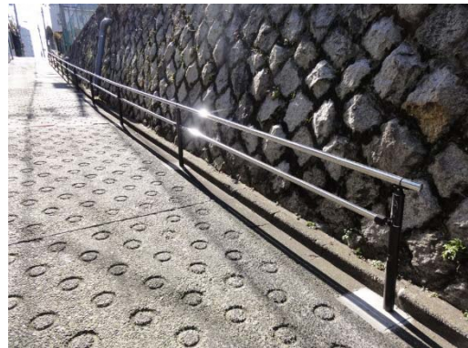
急な坂道への手すりの設置
