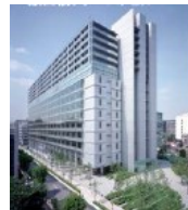
飯田橋ファーストビル
