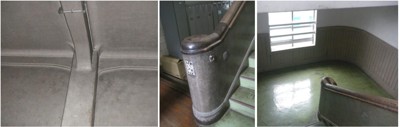
写真-19：旧元町小学校 角をとった丸い意匠（梁・親柱・階段室）
