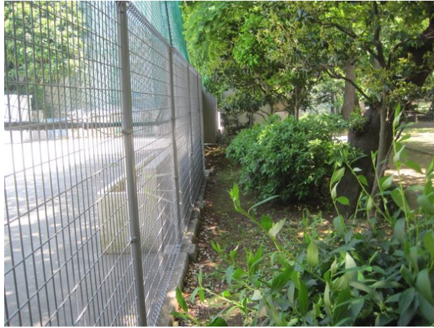
写真-26：元町公園・旧元町小学校 境界部のフェンス
