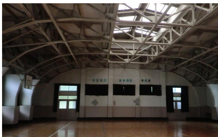
写真-25：旧元町小学校 鉄骨造の体育館
