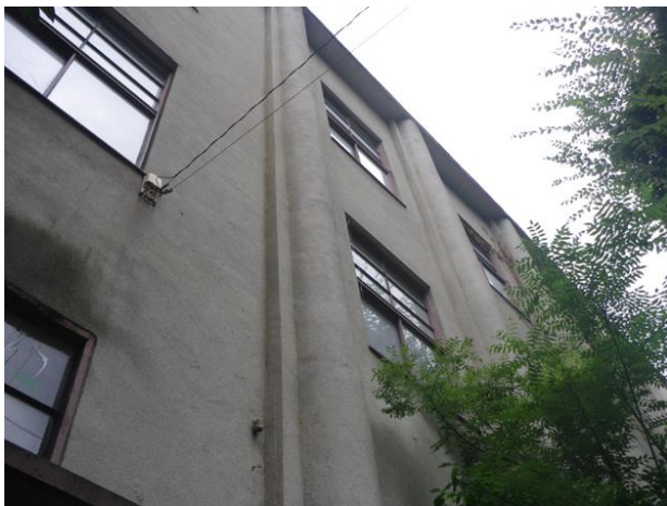
写真-15：旧元町小学校 柱型の外観
