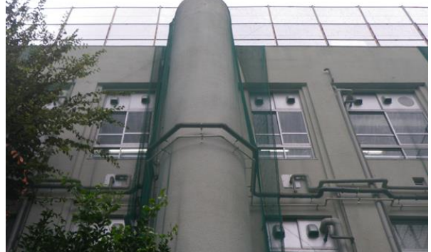
写真-16：旧元町小学校 集中暖房のための煙突跡
