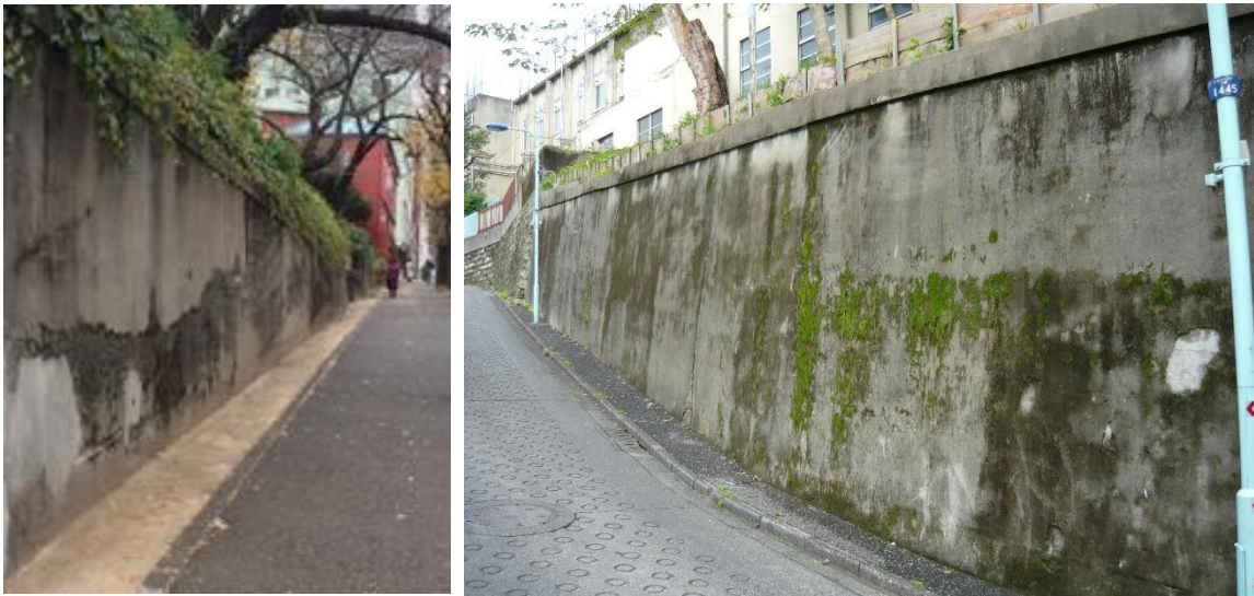
写真-28：元町公園・旧元町小学校 擁壁
