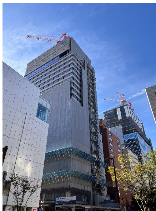
▲現在建設中のヒューリックスクエア 福岡天神（2024年12月竣工予定）
