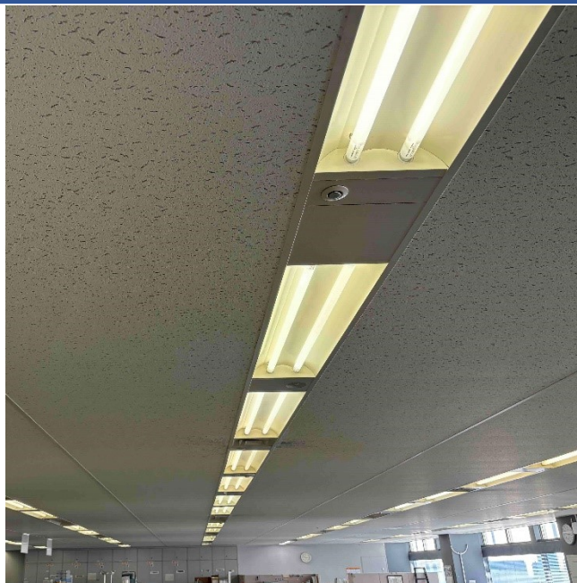
改修前の蛍光灯照明
