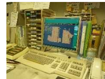
中央監視装置 (先行工事にて改修実施中)
