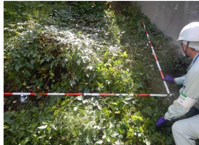
ネットアンカー工の新設
