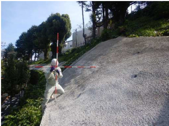
補強土工の新設
