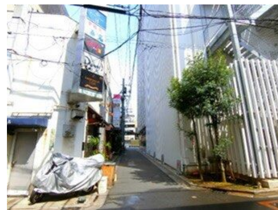
⑤ 幅員4m未満の狭隘道路であり、車両通行が難しい
