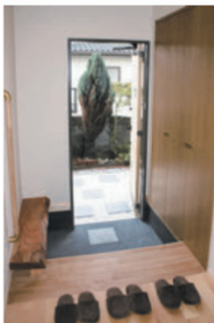
■玄関の段差軽減
