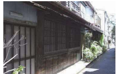
路地沿いに建つ木造の長屋(根津)
